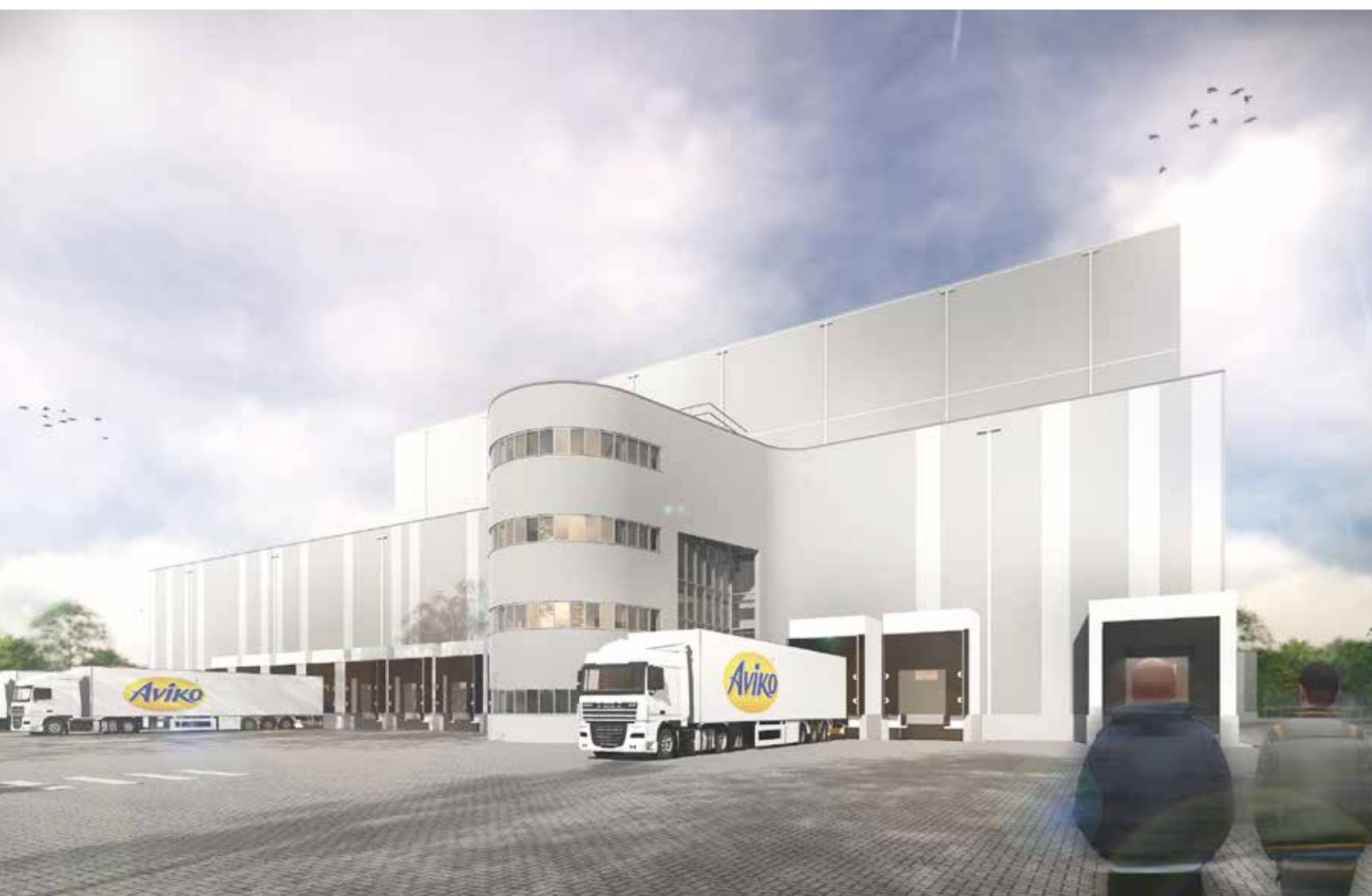
"Onder andere vanwege de hoogte en zichtlijnen wilden we het gebouw laten harmoniseren met de lucht."
